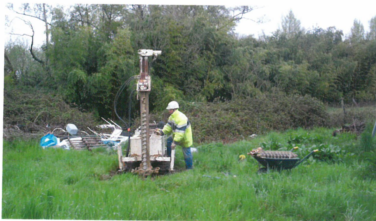
Figure n°11 : Réalisation du sondage S5.
